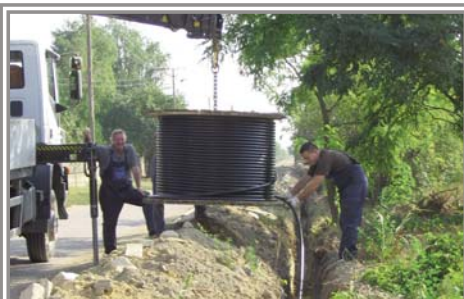
Áramkábel lefektetése 2009-ben
