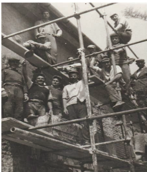
A református templom mögötti iskola felújítása:
